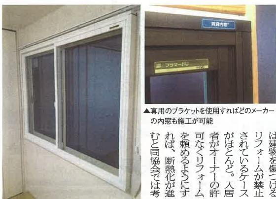
▲専用のブラケットを使用すればどのメーカーの内窓も施工が可能
